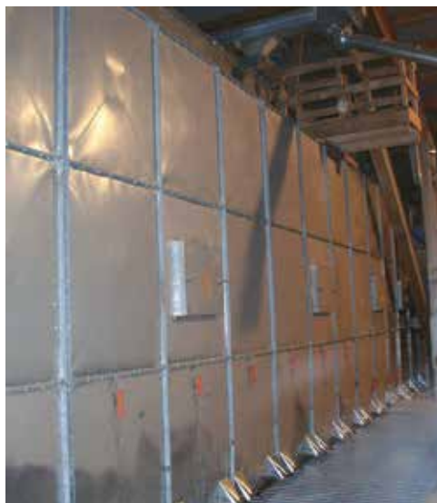
Rechteck-Lagersilo mit Auslaufschieber zur Getreideannahmegosse
