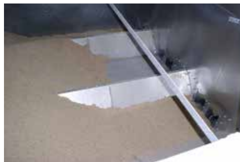
Dachreiter-Belüftungskanäle im eingebauten Zustand
