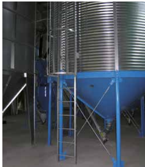
Rundsilo mit Trichterunterbau
