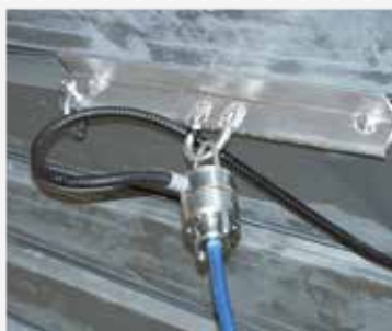
Aufhängung unter Silodach
