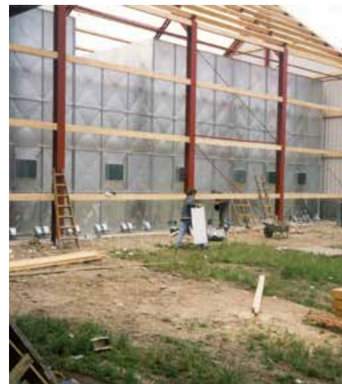
Montage eines Rechteck-Lagersilo mit Fließboden zur pneumatischen Restentleerung
