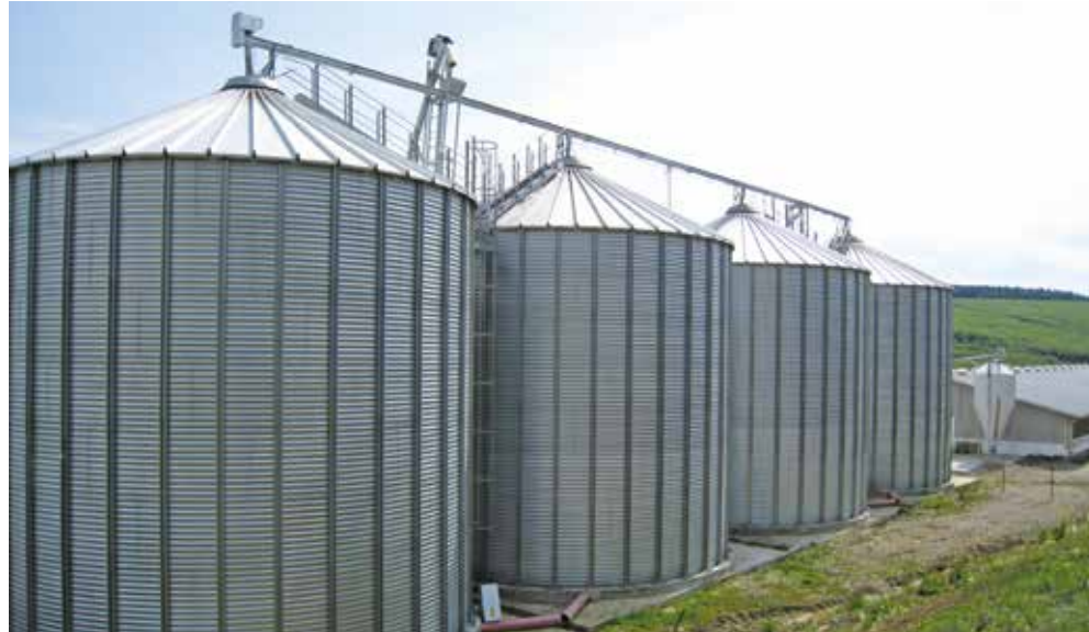
HIMEL Außensilos mit Befüllung über Trogschnecken
