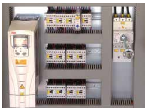
Frequenzumformer in Schaltschrank eingebaut
