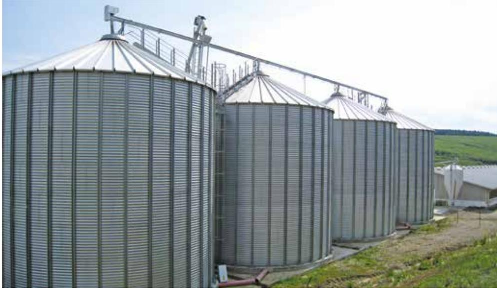
HIMEL Außensilos mit Befüllung über Trog-schnecken
