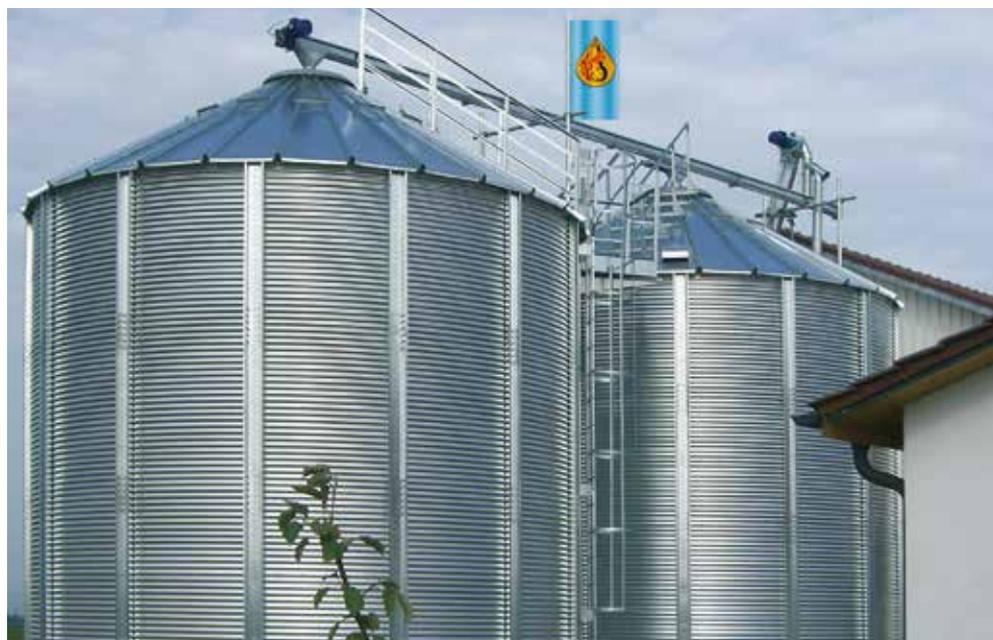
HIMEL Aussensiloanlage mit Kettenelevator und Trogschnecke
